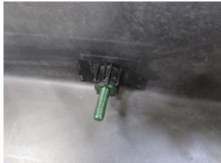
Nach dem Aushärten demonstrieren Sie bitte die Haltevorrichtungen und säubern Sie sie von vorhandenen Kleberückständen.
